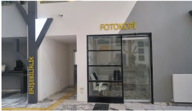
Resim 22. Açılır-kapanır kapı. (Engelli Kullanım İmkanları, 2019)
