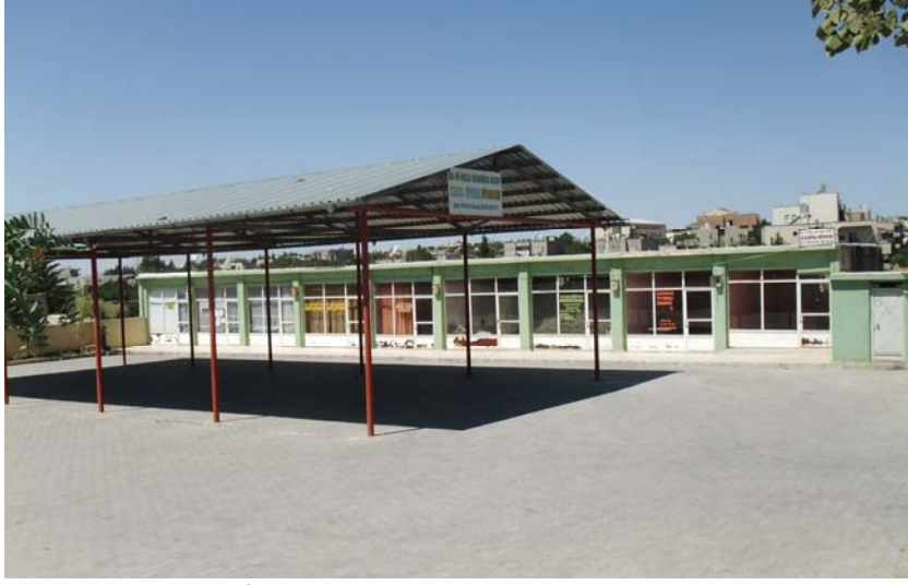
Foto 38: Kâhta İlçelerarası Minibüs Garajı (M.Sırrı Turanlı Caddesi Üzerinde Bulunan Garaj Alanı Geçmişte Şehir Merkez Otogarı Olarak Kullanılmıştır)
