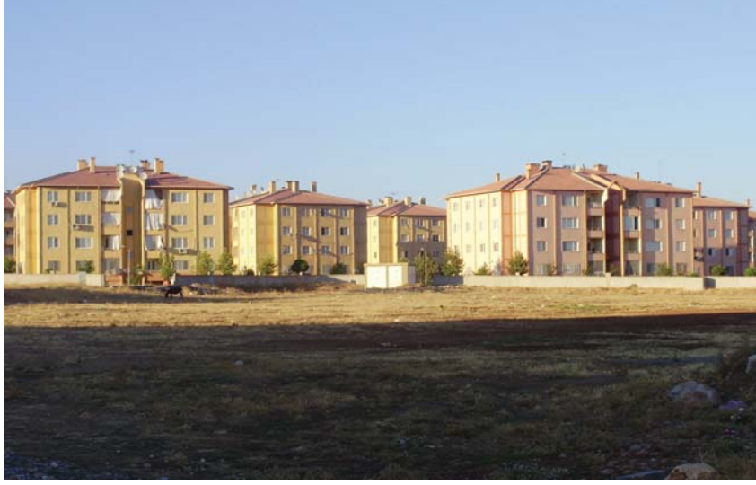
Foto 10: Şehrin Kuzey Sınırında İnşa Edilmiş Olan TOKİ Evleri
