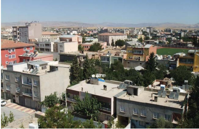
Foto 15: Kâhta Şhrinde Biriket Kullanılarak İnşa Edilmiş Betonarme Yapılar (2011)
