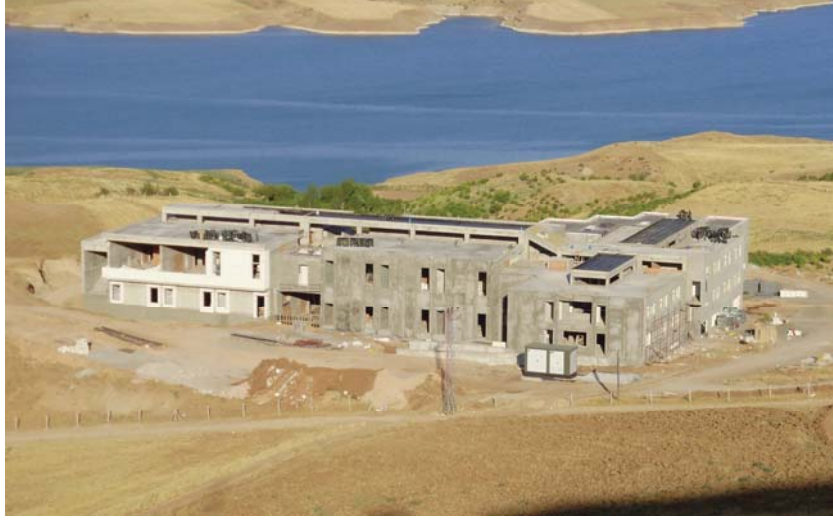
Foto 48: Kâhta Meslek Yüksekokulunun Atatürk Barajı Kıyısındaki Yeni Kampüsü
