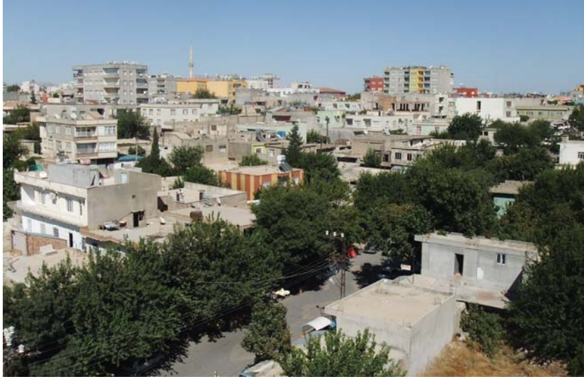
Foto 17: Kâhta Şhrinde Değişen Konut Görünümü ve Çok Katlı Betonarme Yapılar (2011)
