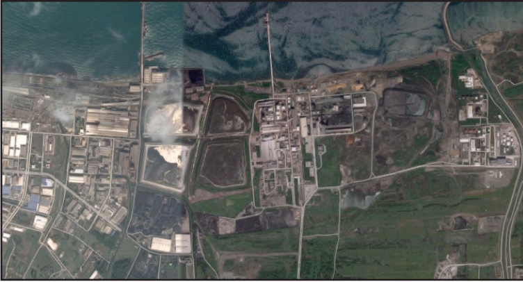
Fotoğraf 14. Samsun-Tekke köyde işletmeye alınan bakır izabe tesisleri, 2004 yılında özelleştirilmiştir. Fabrikanın kendisi ve atıklarının depolandığı alanlar, deniz kıyısında yer almaktadır.
