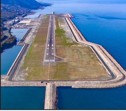
Fotoğraf 11. 2011 yılında yapımına başlanan Ordu-Giresun Havaalanı 2014 yılında faaliyete geçmiştir. Karadeniz'de görülen sert fırtınaların havaalanına zarar vermemesi için deniz tarafına 5,5 metre yüksekliğinde duvar yapılarak denizin etkisi azaltılmaya çalışılmıştır.
