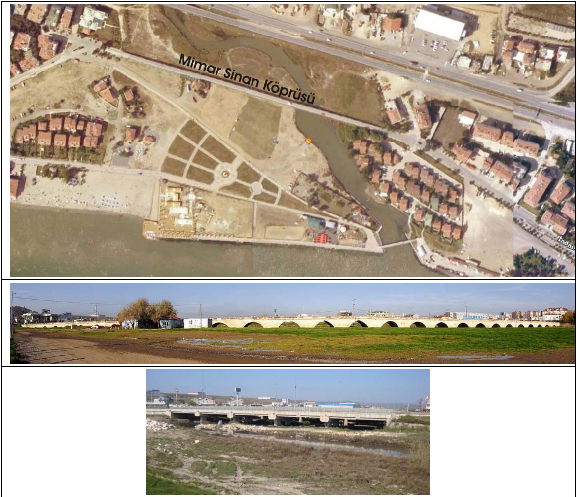
Foto 5. Silvri, Mimar Sinan Köprüsü ve aynı yerdeki D100 karayolu köprüsünün, sıra dışı yağışlar için akıma uygunluk karşılaştırması, sel ve taşkınlar için yaklaşım farklılığını ortaya koymaktadır.
