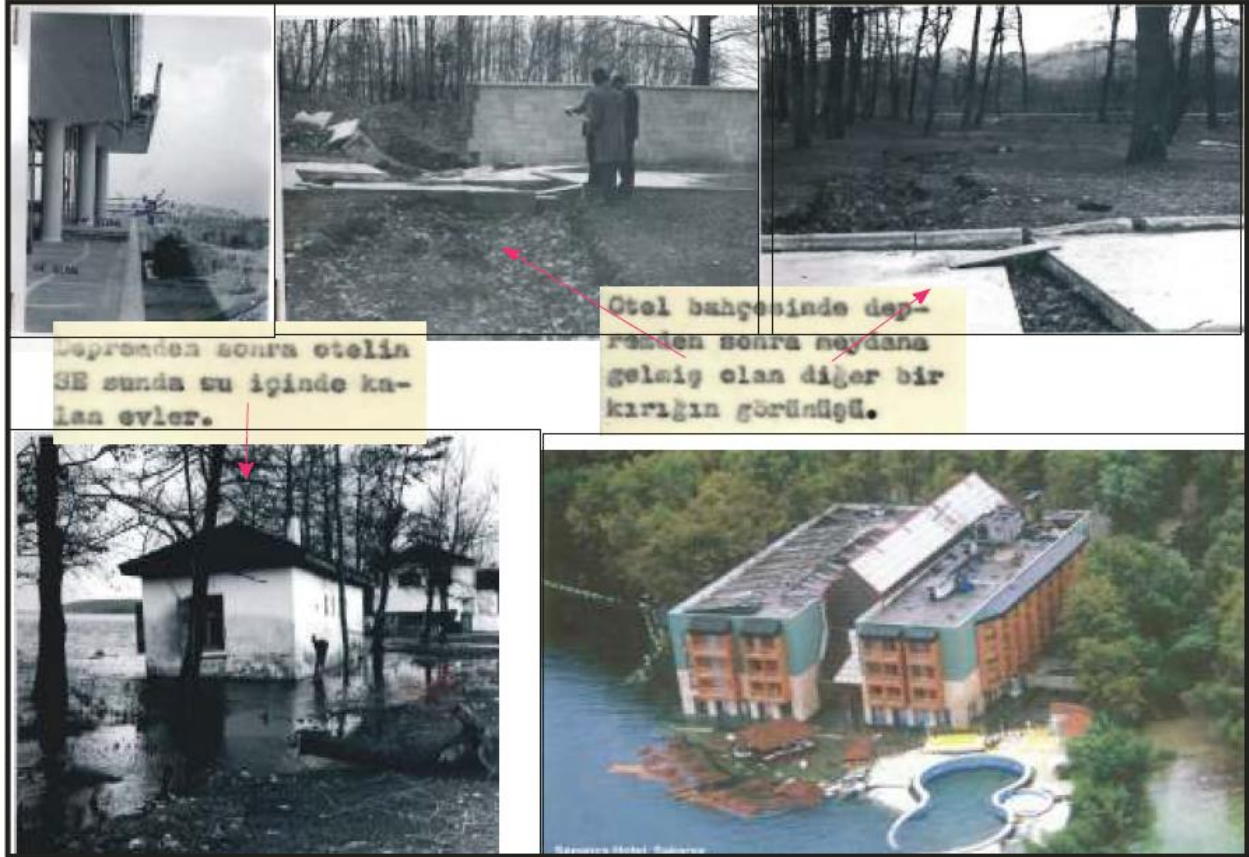
Şekil 1. Sapanca Vakıf Otelinin ve civarındaki alanın, 22 Temmuz 1967 depreminden aldığı hasarlar ve zemin deformasyonları, 25.03.1968 tarihli Jeolojik Etüt raporunda AİGM mühendisi Jeolog Ziya Barut tarafından anlatılmaktadır. Sonuç kısmında ise, binada alınacak tedbir, tamir ya da güçlendirmenin, kısa ve uzun vadede tekrarlayan depremlerle bir fayda getirmeyeceğini belirtmektedir. Siyah – beyaz resimler 1967 depreminin yol açtığı bina ve zemin deformasyonlarını, renkli resimler ise 17 Ağustos 1999 depreminden sonra ağır hasara uğrayarak yan yatan ve Sapanca Gölüne kavuşan, daha sonrada yıkılan Vakıf Oteli göstermektedir.
