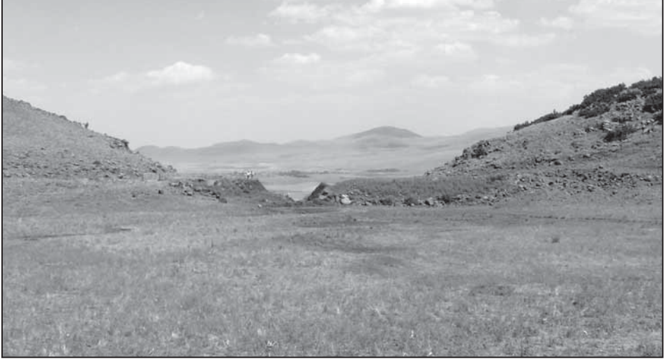
Resim 5: Akkent (Gavurbendi) Barajı.
