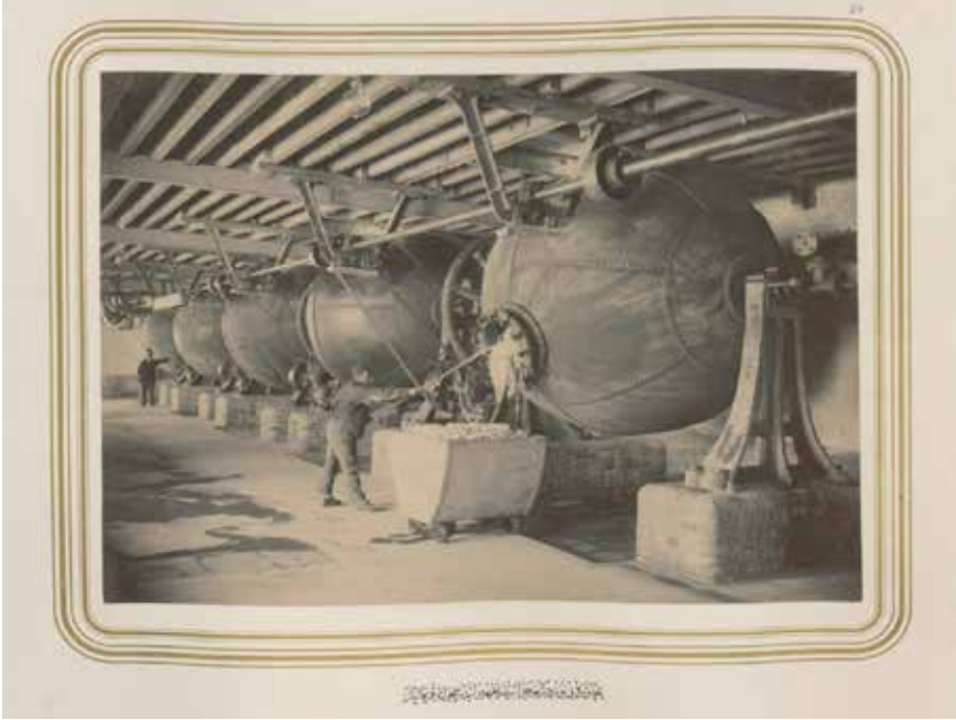
Fotoğraf.3. Kâğıt Hamurunu 100 Derecelik Sıcaklıkla Temizleyen Dönen Kazanlar
