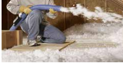
Şekil 3: Püskürtme tekniği uygulaması [19]
