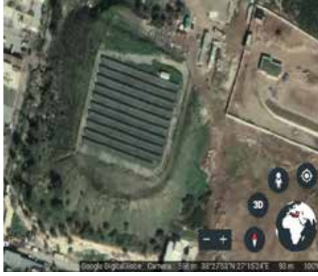
Şekil 5. GES'e ait genel görünüm
