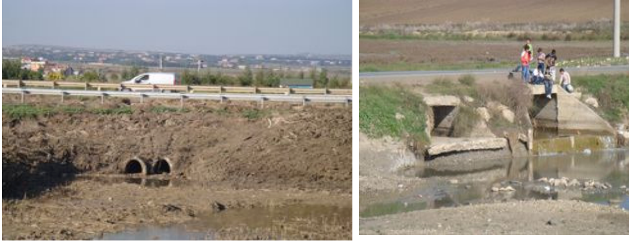
Foto 4: Dolgu yükseklikleri ve yüzeysel drenaj için yol dolguları içinde bırakılan kutu ya da boru menfezler.
