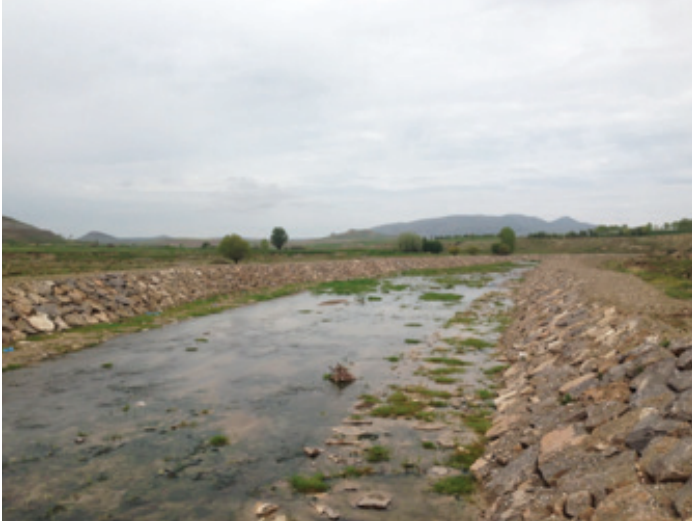
Şekil 5. Karasu Çayı üzerinde Devlet Su İşleri Genel Müdürlüğü (DSİ) 'nün yaptığı dere islah çalışması
