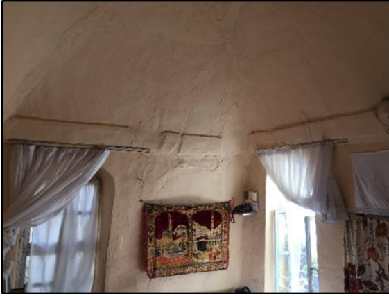
Fotoğraf 7. Kubbe şekilli tavanların çökmemesi amacıyla destek olarak konulan hatıl(tahta) örneği
