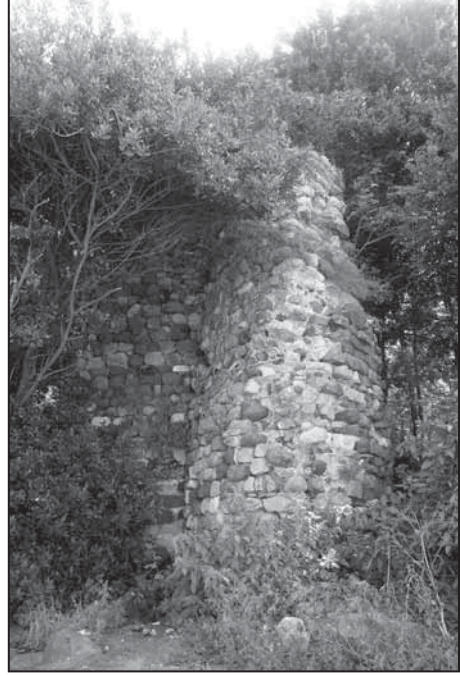
Resim 8: Sur. Payanda- onarım.
