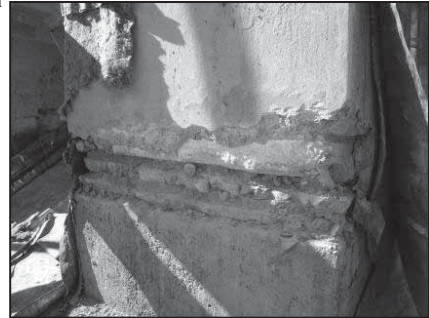
Resim 6: Antoniadi ve Swift'in restitüsyonları esas alınarak güneydoğu yönündeki uçan payandanın izlerinin araştırıldığı kasnak yüzeyi (Hasan Fırat Diker)
