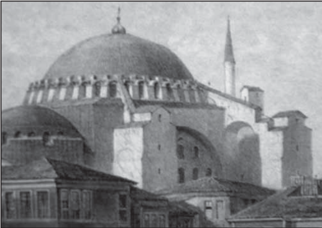
Çizim 3: Fossati onarımları öncesi uçan payandalar henüz kaldırılmadan Ayasofya görünümünden detay(Fossati, Gaspare, Aya Sofia Constantinople as Recently Restored by Order of H.M. The Sultan Abdul Mejid, Londra,1852)
